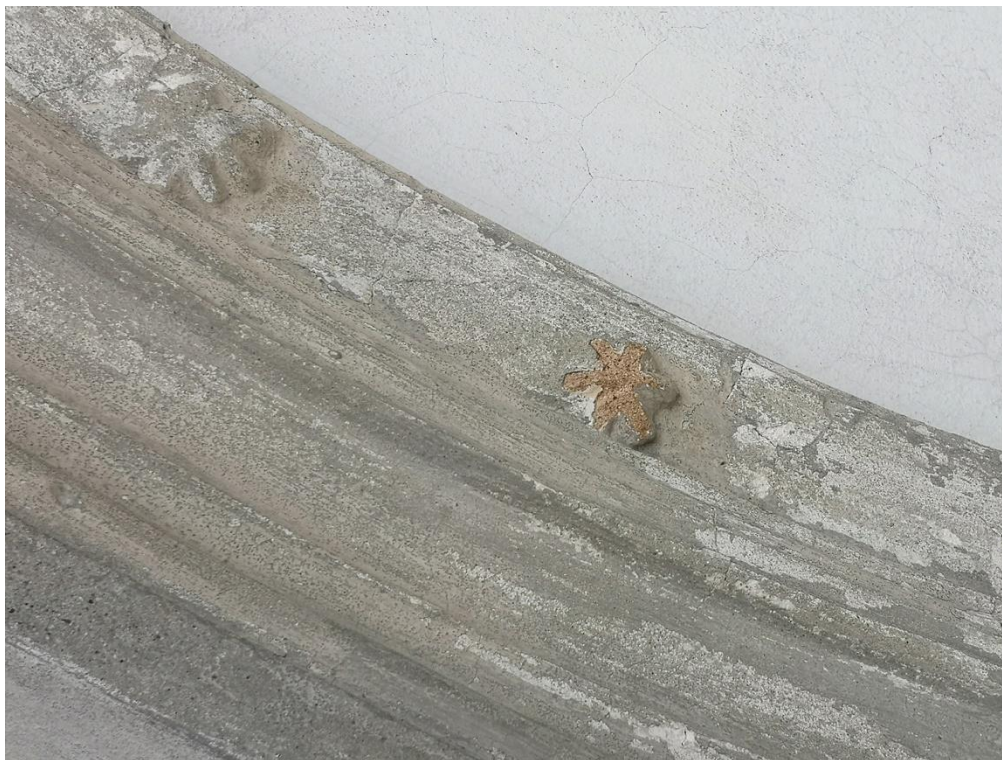
Fot 6. Kościół cmentarny, pw. św. Stanisława b. m. w Szczepanowie, gm. Brzesko. Badania stratygraficzne elewacji. Elewacja frontowa – fragment łuku na d herbem usytuowanym powyżej wejścia głównego.
