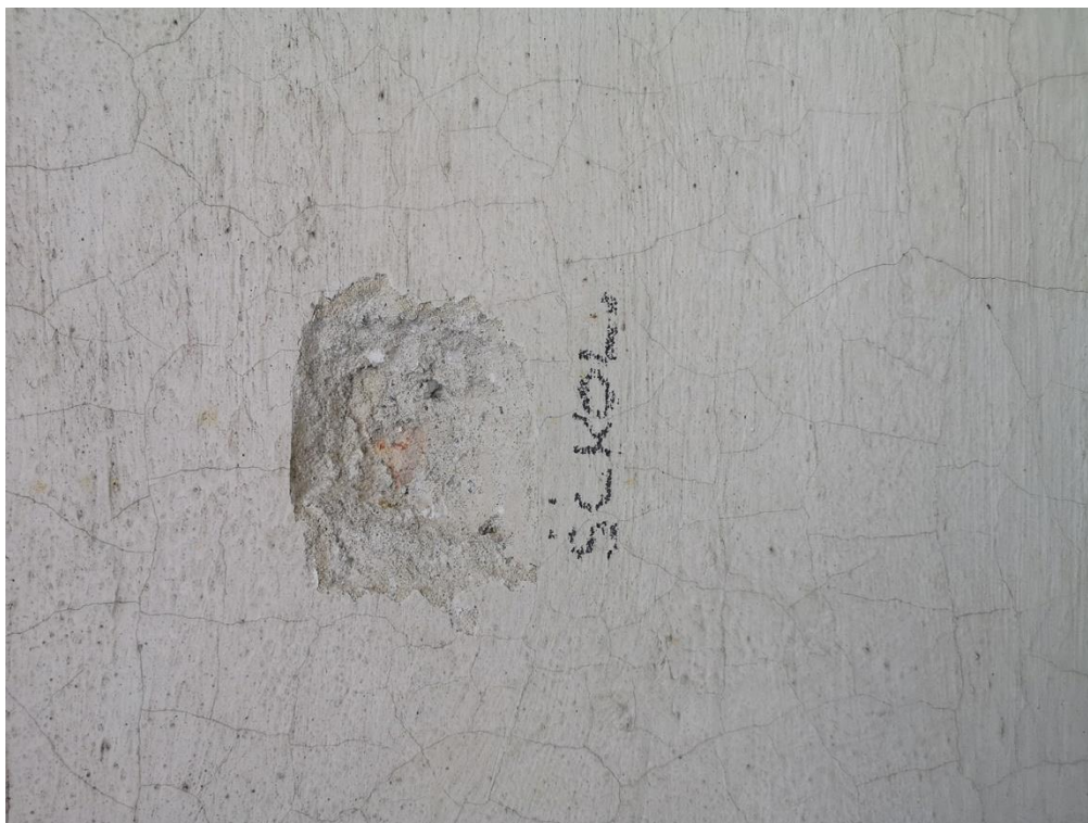
Fot 15. Kościół cmentarny, pw. św. Stanisława b. m. w Szczepanowie, gm. Brzesko. Badania stratygraficzne elewacji. Elewacja frontowa – tynki gładkie na ścianie kolankowej.
