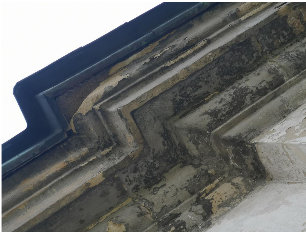
Fot 1. Kościół cmentarny, pw. św. Stanisława b. m. w Szczepanowie, gm. Brzesko. Badania stratygraficzne elewacji. Elewacja frontowa - gzyms attyki.
