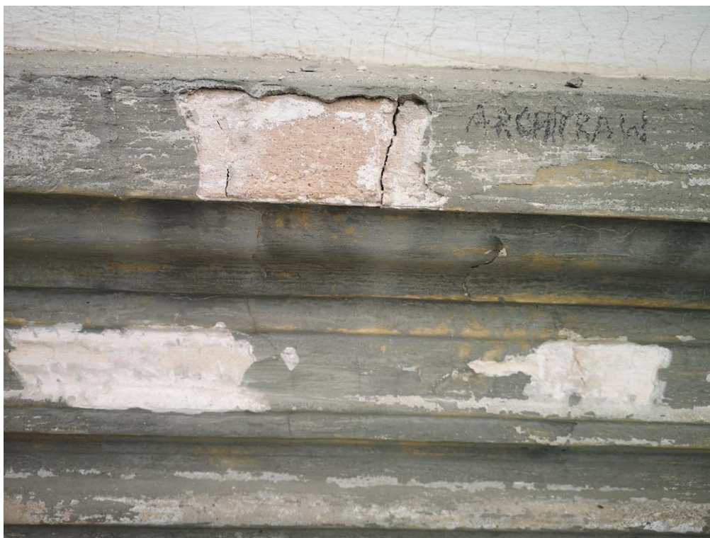
Fot 4. Kościół cmentarny, pw. św. Stanisława b. m. w Szczepanowie, gm. Brzesko. Badania stratygraficzne elewacji. Elewacja frontowa – gzyms architravu.
