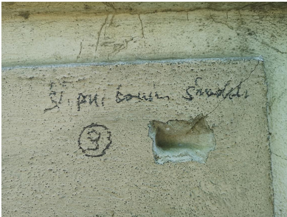
Fot 10. Kościół cmentarny, pw. św. Stanisława b. m. w Szczepanowie, gm. Brzesko. Badania stratygraficzne elewacji. Bonia na ścianie północnej.
