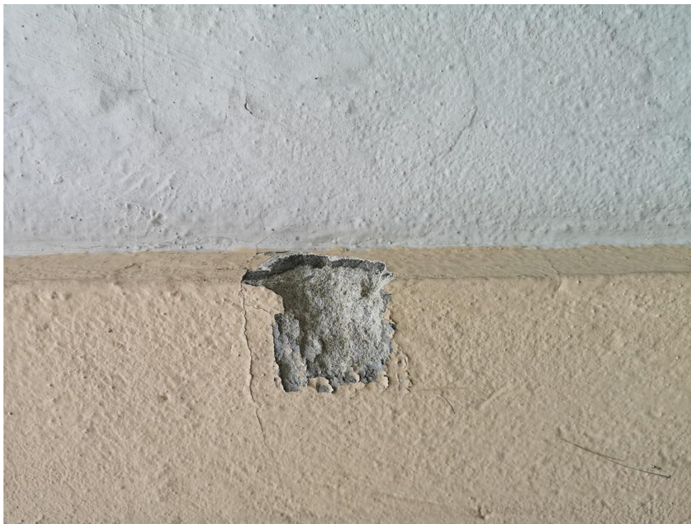
Fot 9. Kościół cmentarny, pw. św. Stanisława b. m. w Szczepanowie, gm. Brzesko. Badania stratygraficzne elewacji. Opaska okna na ścianie prezbiterium.
