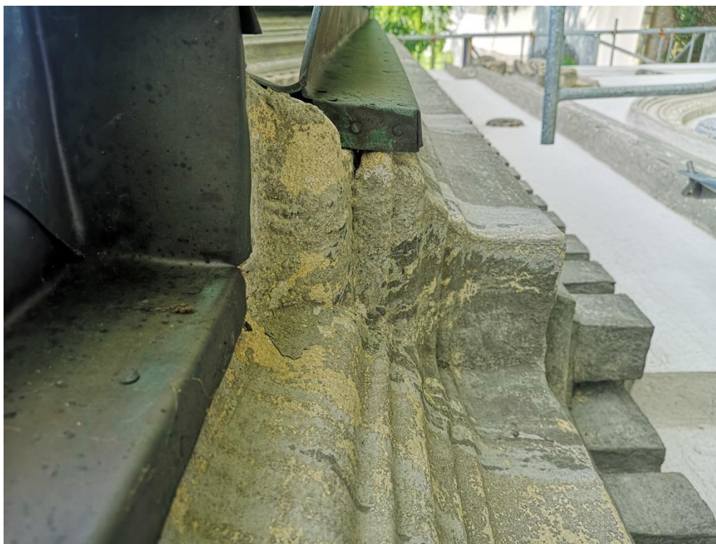
Fot 2. Kościół cmentarny, pw. św. Stanisława b. m. w Szczepanowie, gm. Brzesko. Badania stratygraficzne elewacji. Elewacja frontowa - gzyms wieńczący, pod attyką.
