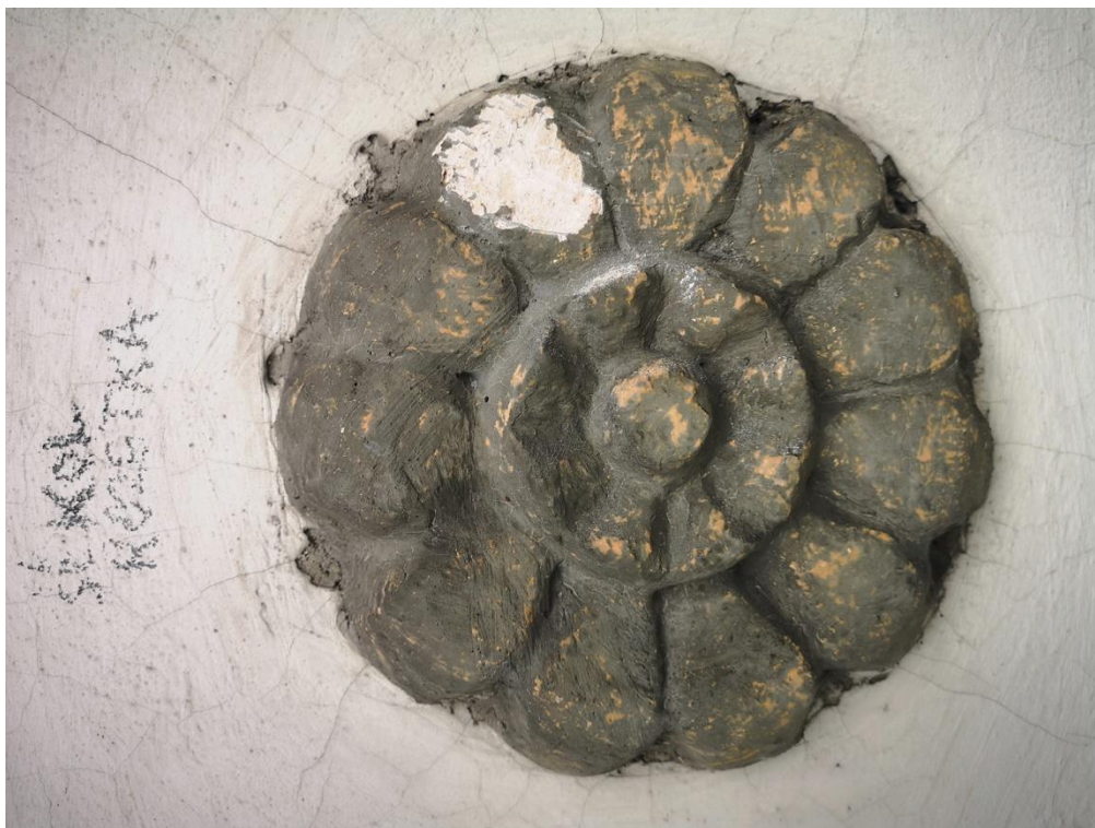
Fot 3. Kościół cmentarny, pw. św. Stanisława b. m. w Szczepanowie, gm. Brzesko. Badania stratygraficzne elewacji. Elewacja frontowa rozetka na ścianie kolankowej.
