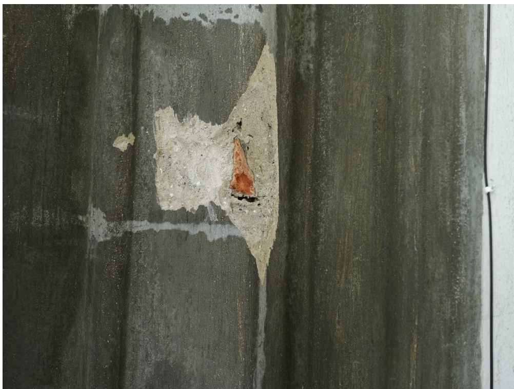
Fot 8. Kościół cmentarny, pw. św. Stanisława b. m. w Szczepanowie, gm. Brzesko. Badania stratygraficzne elewacji. Elewacja boczna – gzyms wieńczący.
