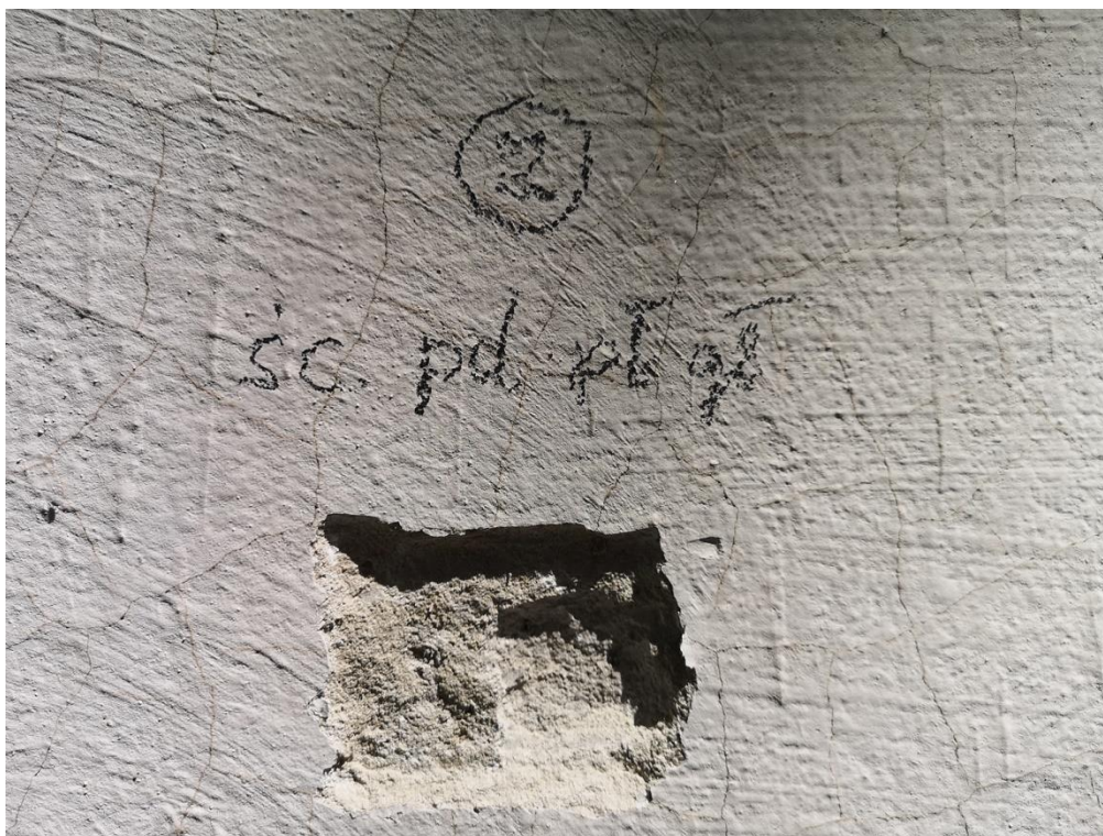
Fot 18. Kościół cmentarny, pw. św. Stanisława b. m. w Szczepanowie, gm. Brzesko. Badania stratygraficzne elewacji. Tynki gładkie na powierzchni ściany południowej, strona wschodnia.
