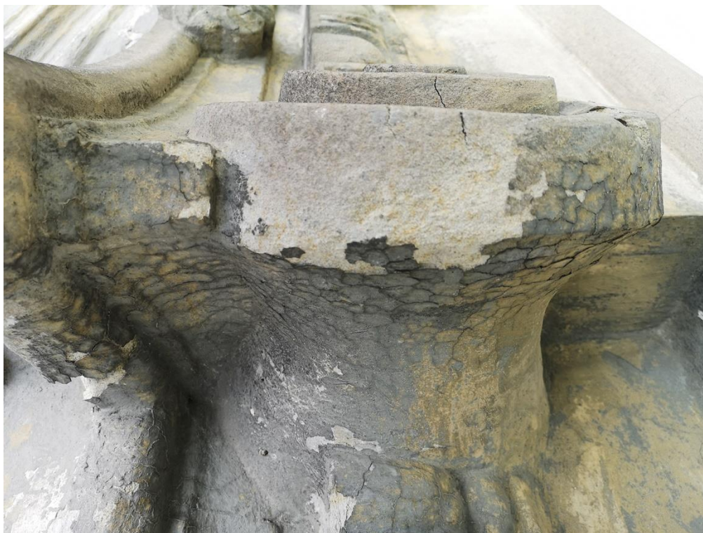
Fot 5. Kościół cmentarny, pw. św. Stanisława b. m. w Szczepanowie, gm. Brzesko. Badania stratygraficzne elewacji. Elewacja frontowa – fragment jednej z głowic pilastrów.
