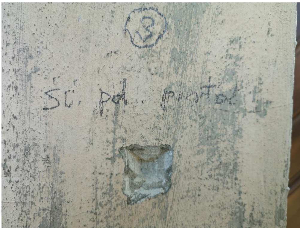
Fot 12. Kościół cmentarny, pw. św. Stanisława b. m. w Szczepanowie, gm. Brzesko. Badania stratygraficzne elewacji. Opaska portalu wejścia na ścianie południowej.
